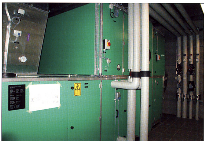
Gestion de la ventilation/climatisation, avec un potentiel de 18'850m3 d'air pulsé dans le bâtiment.
